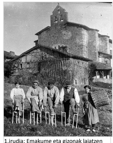
1.irudia: Emakume eta gizonak laiatzen
